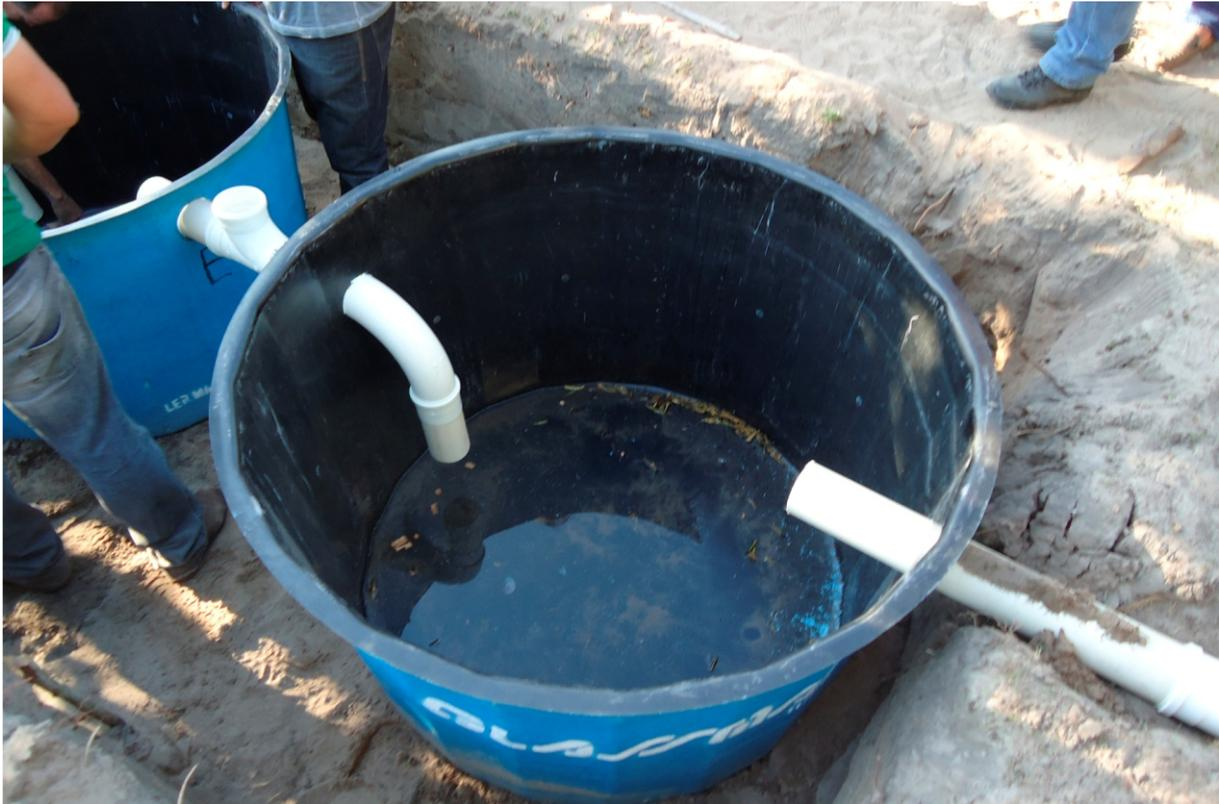
Figura 6. Esquema da tubulação de entrada e saída (curva longa 90°). (Foto: Renato Marmo)
