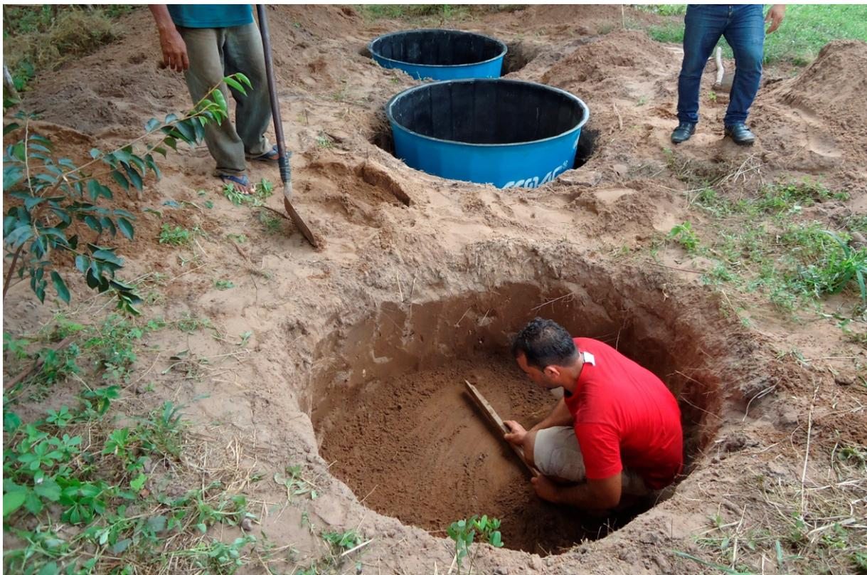
Figura 5. Escavação das caixas e nivelamento do fundo com o uso de uma régua em madeira. (Foto: Renato Marmo)
