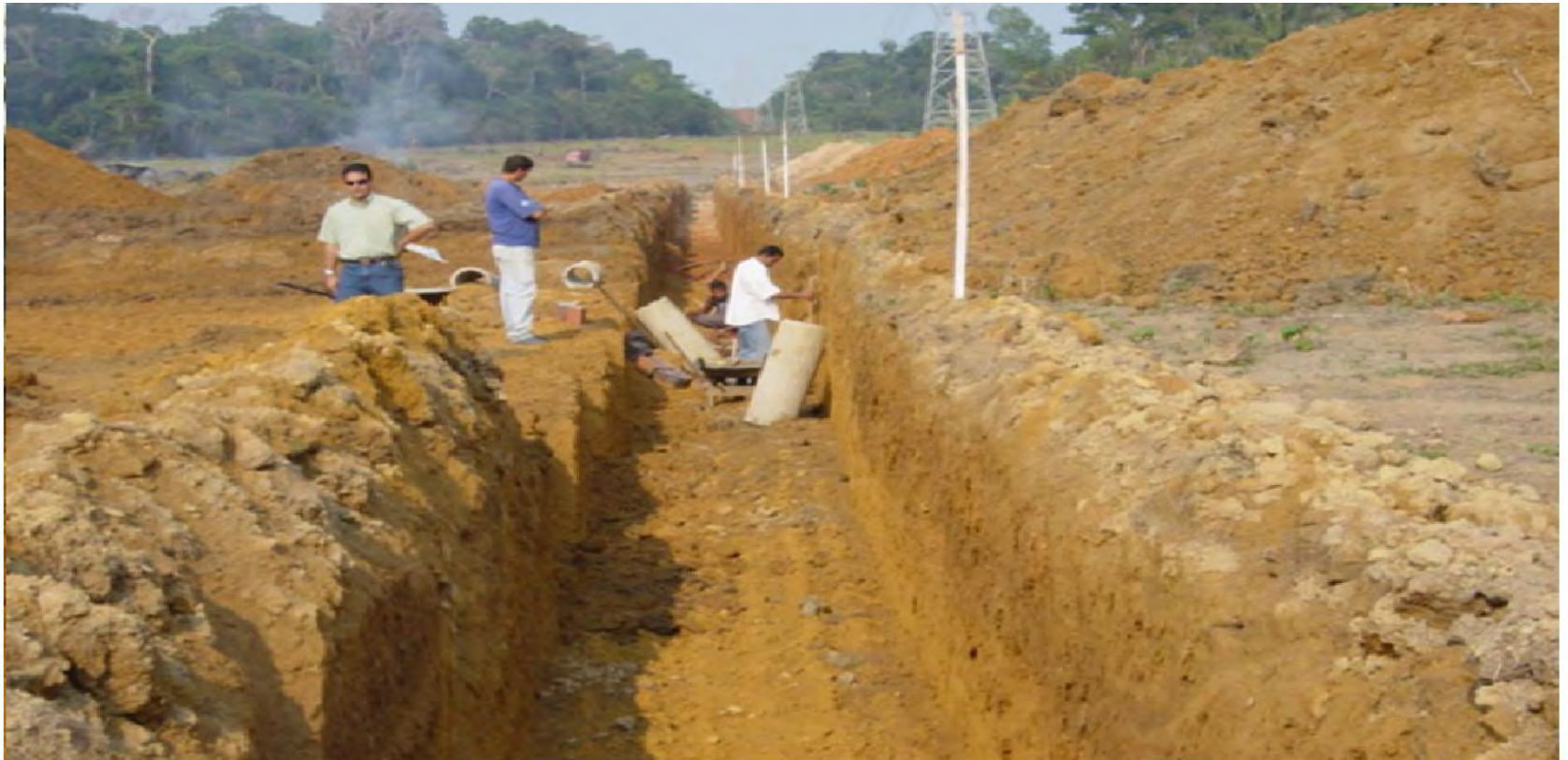
CONSTRUÇÃO DE CANAIS DE DRENAGEM E ABASTECIMENTO
